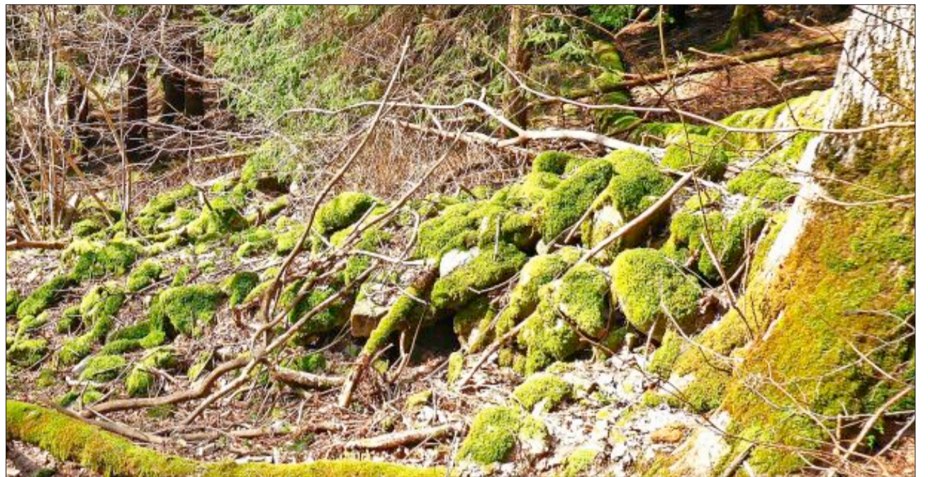
Stumme Zeitzeugen aus Stein: Eine der bis heute erhalten gebliebenen Mauern im Wald östlich von Elbenschwand.
